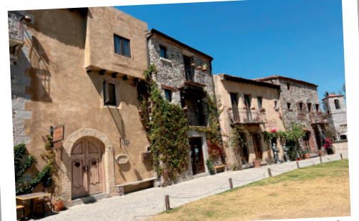
Vista exterior de uno de los edificios de Villa Toscana que ubica suites y departamentos loft.
